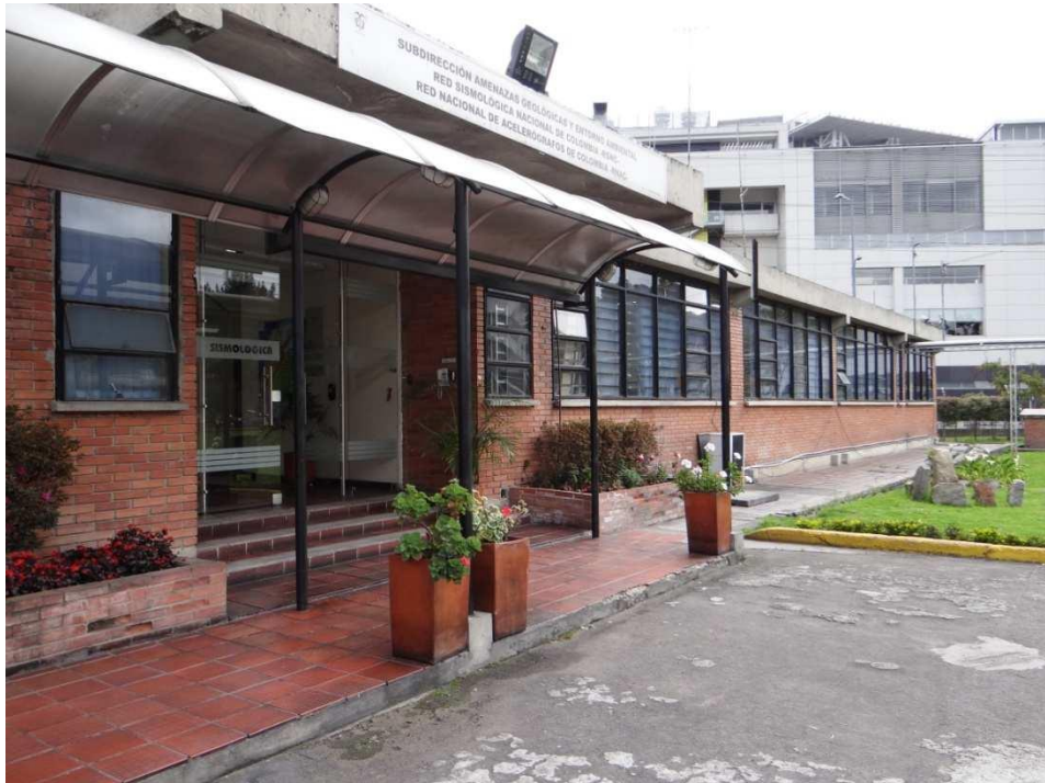
Figura 5: Estructura de muros portantes, se requiere introducir muros de concreto que eliminarán muchas de las ventanas.
