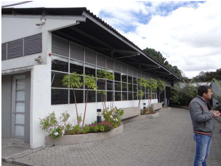
Figura 7: Requerimiento de muros de concreto en fachada
